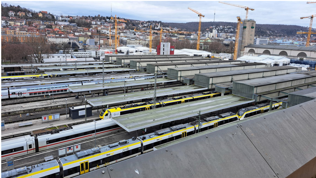
Abbildung 1: Blick auf das Baufeld bei Messbeginn am 19.02.2024
