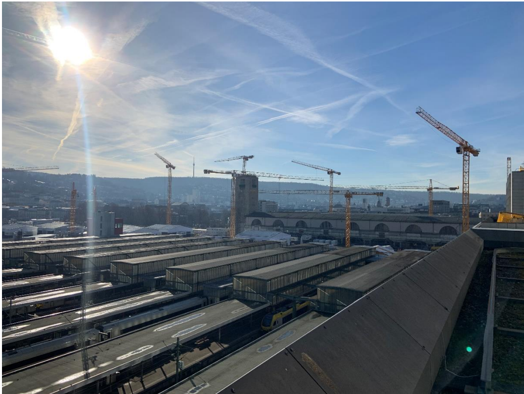
Abbildung 2: Blick auf das Baufeld bei Messende am 29.01.2024
