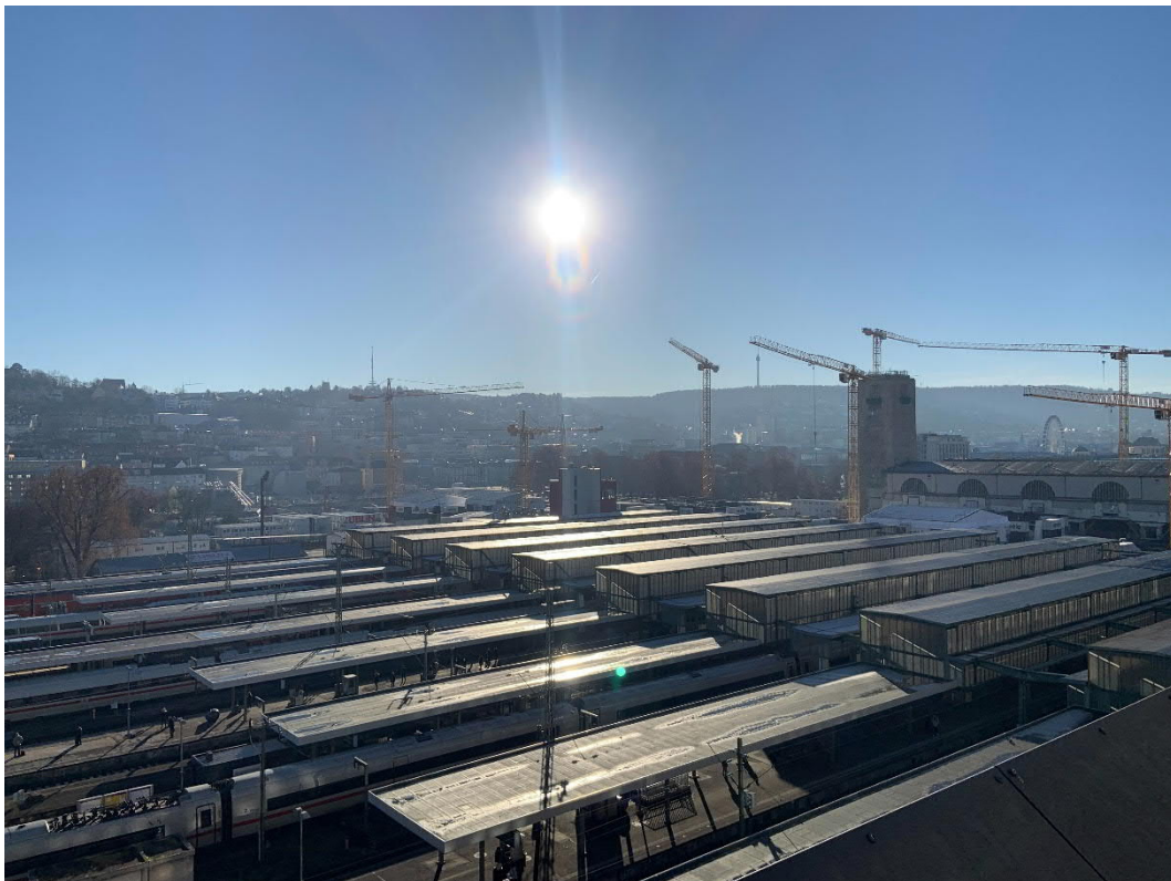
Abbildung 2: Blick auf das Baufeld bei Messende am 18.12.2023
