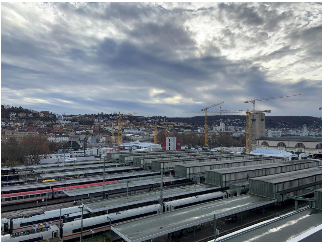
Abbildung 1: Blick auf das Baufeld bei Messbeginn am 11.12.2023
