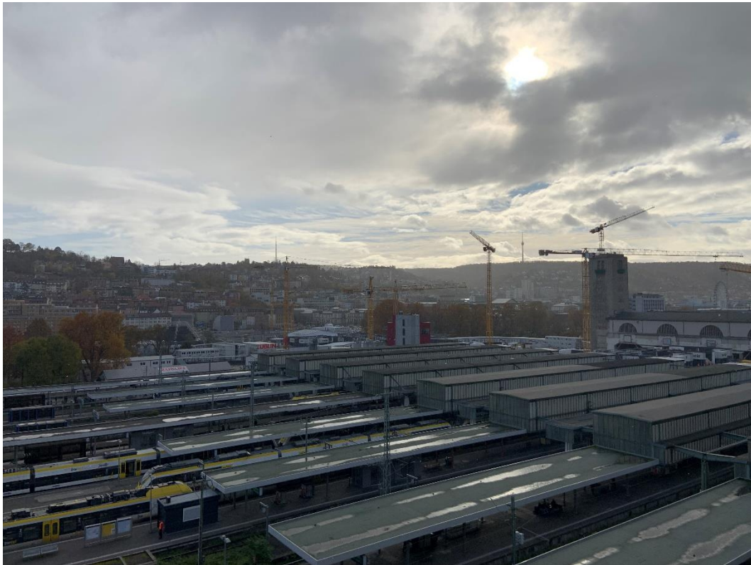
Abbildung 2: Blick auf das Baufeld bei Messende am 20.11.2023
