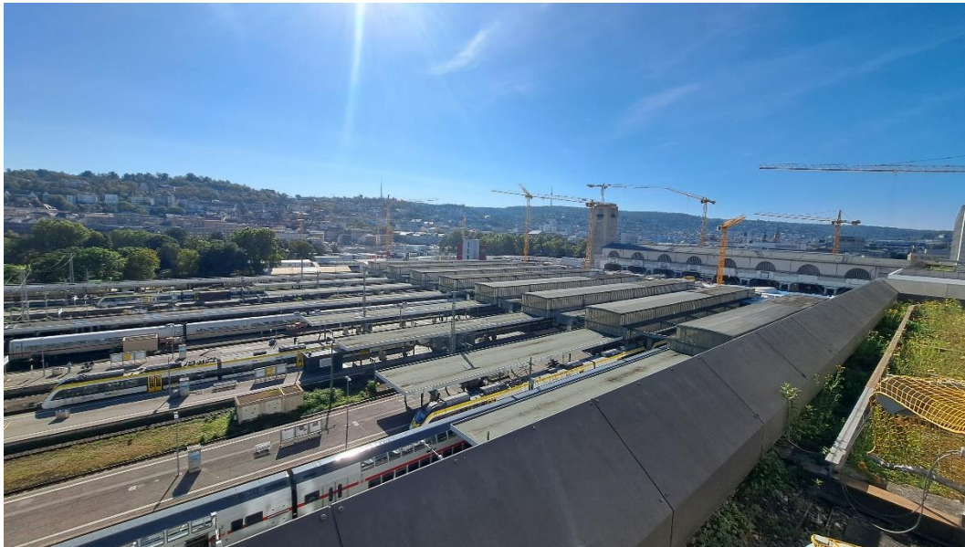
Abbildung 2: Blick auf das Baufeld bei Messende am 25.09.2023
