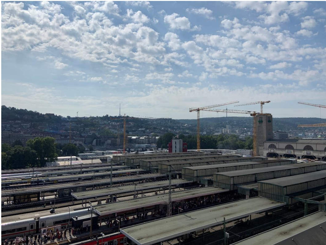
Abbildung 2: Blick auf das Baufeld bei Messende am 21.08.2023
