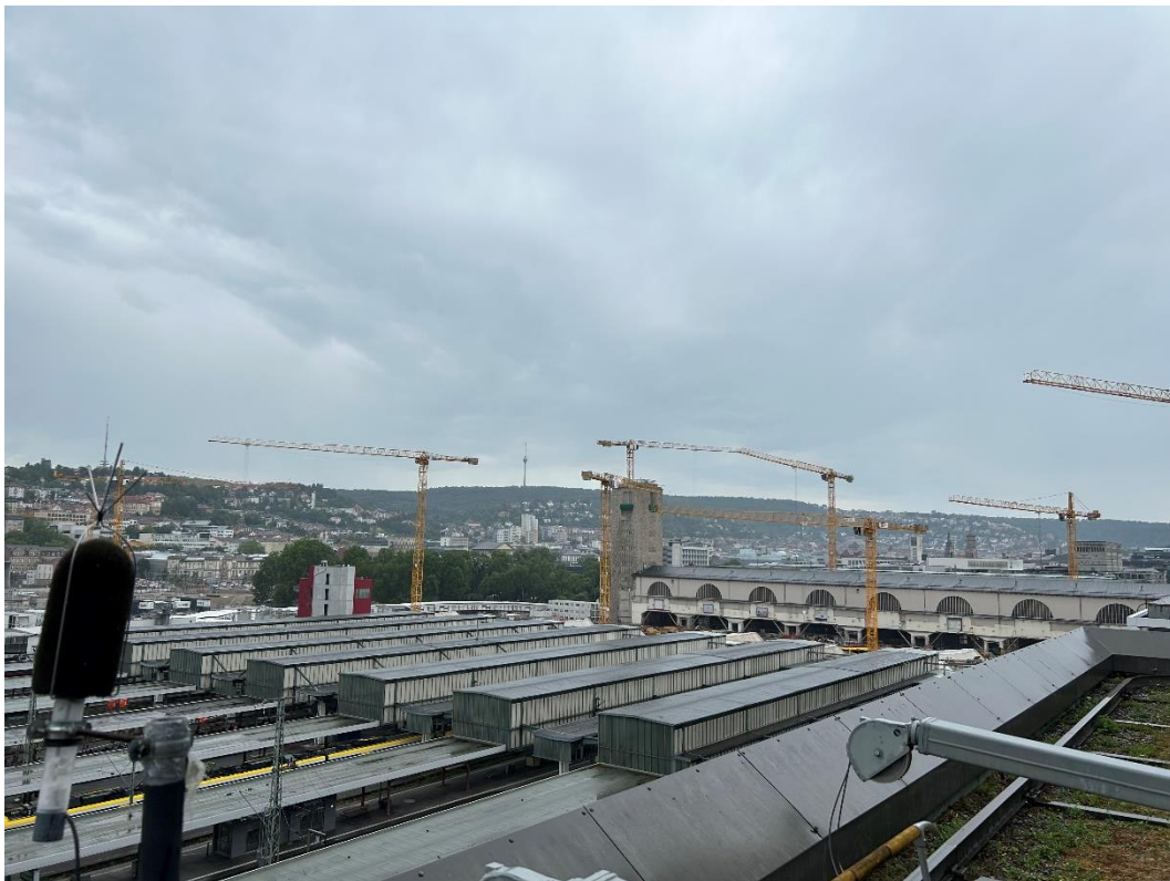
Abbildung 2: Blick auf das Baufeld bei Messende am 24.07.2023
