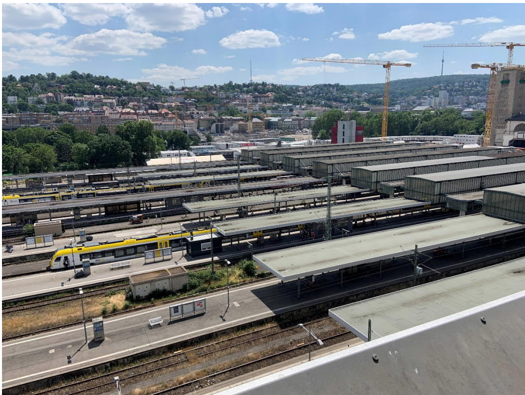
Abbildung 1: Blick auf das Baufeld bei Messbeginn am 12.06.2023
