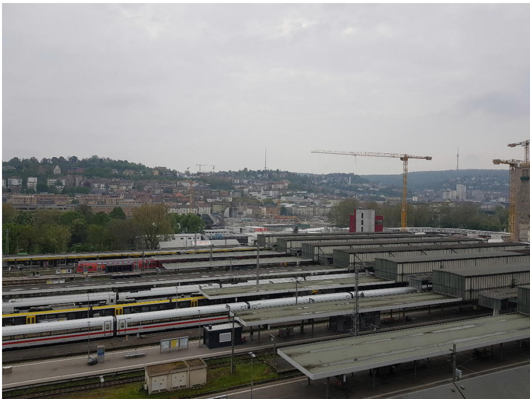
Abbildung 1: Blick auf das Baufeld bei Messbeginn am 02.05.2023
