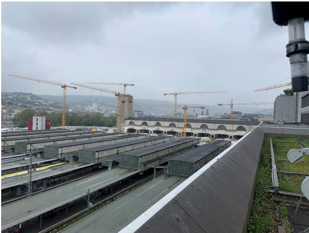
Abbildung 2: Blick auf das Baufeld bei Messende am 09.05.2023
