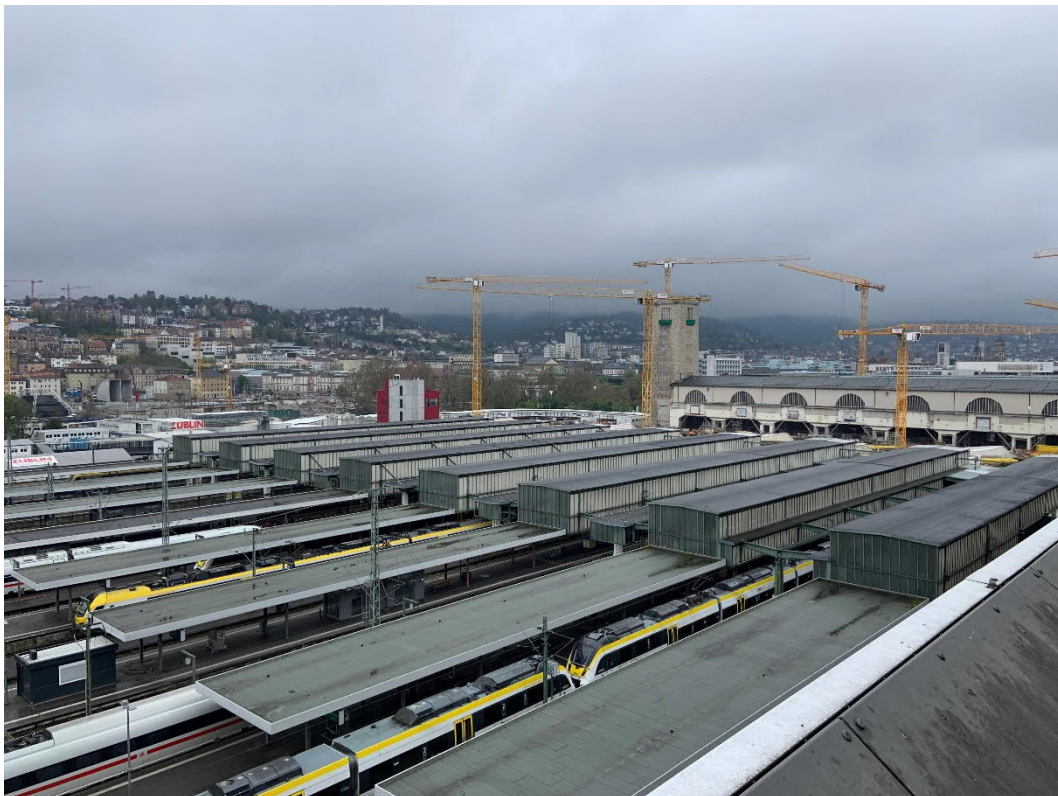
Abbildung 2: Blick auf das Baufeld bei Messende am 17.04.2023
