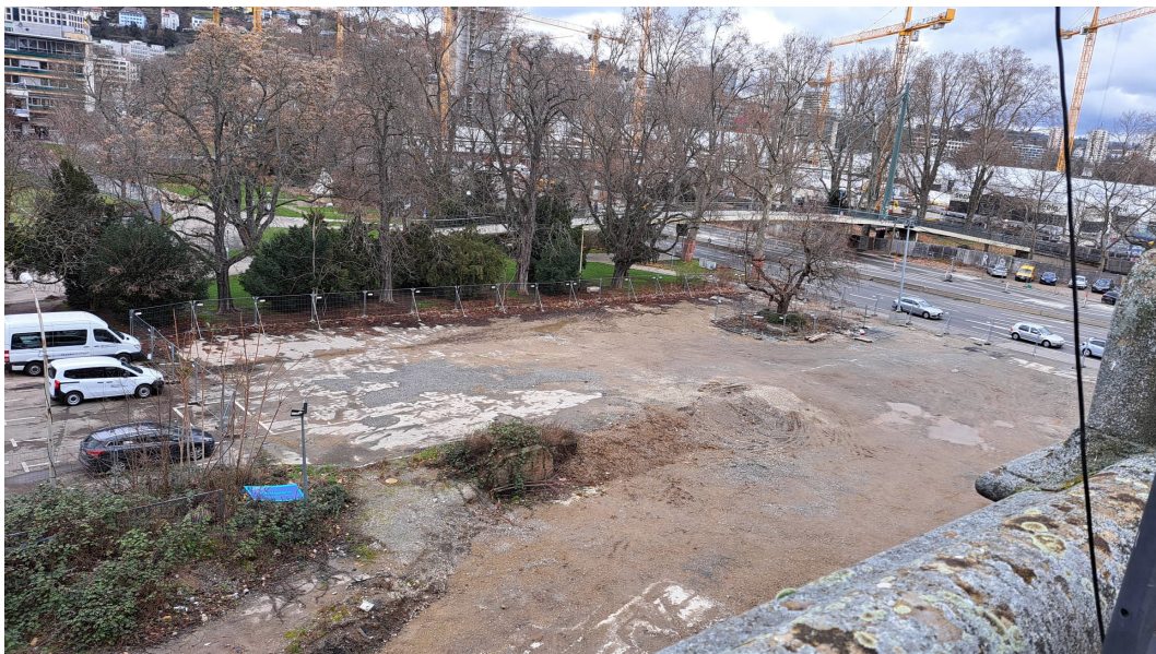
Abbildung 1: Blick auf das Baufeld bei Messbeginn am 19.02.2024
