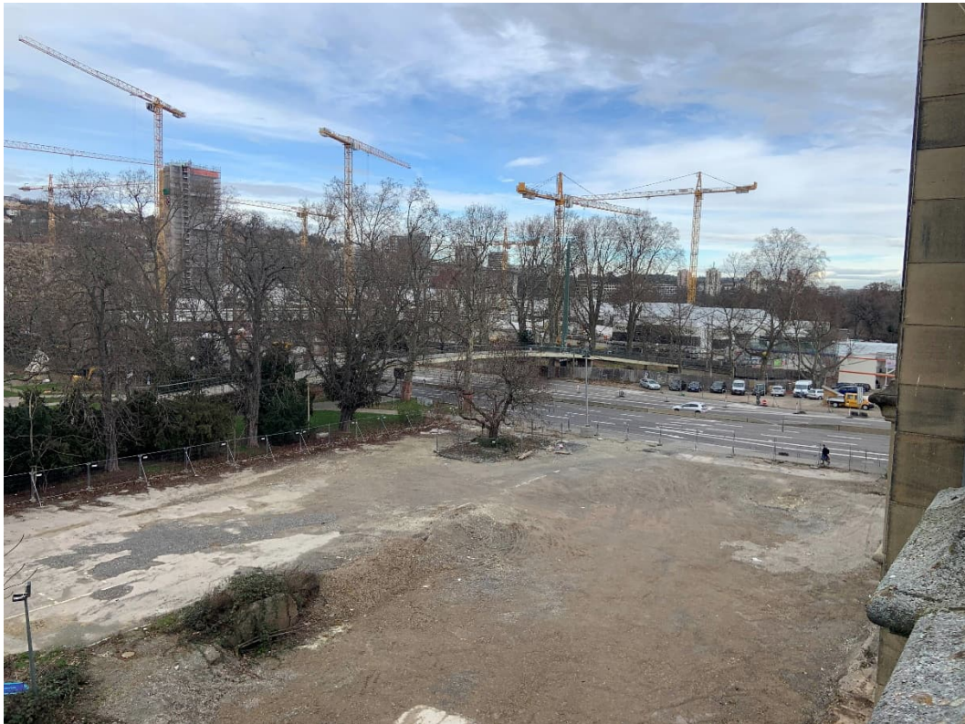
Abbildung 2: Blick auf das Baufeld bei Messende am 26.02.2024
