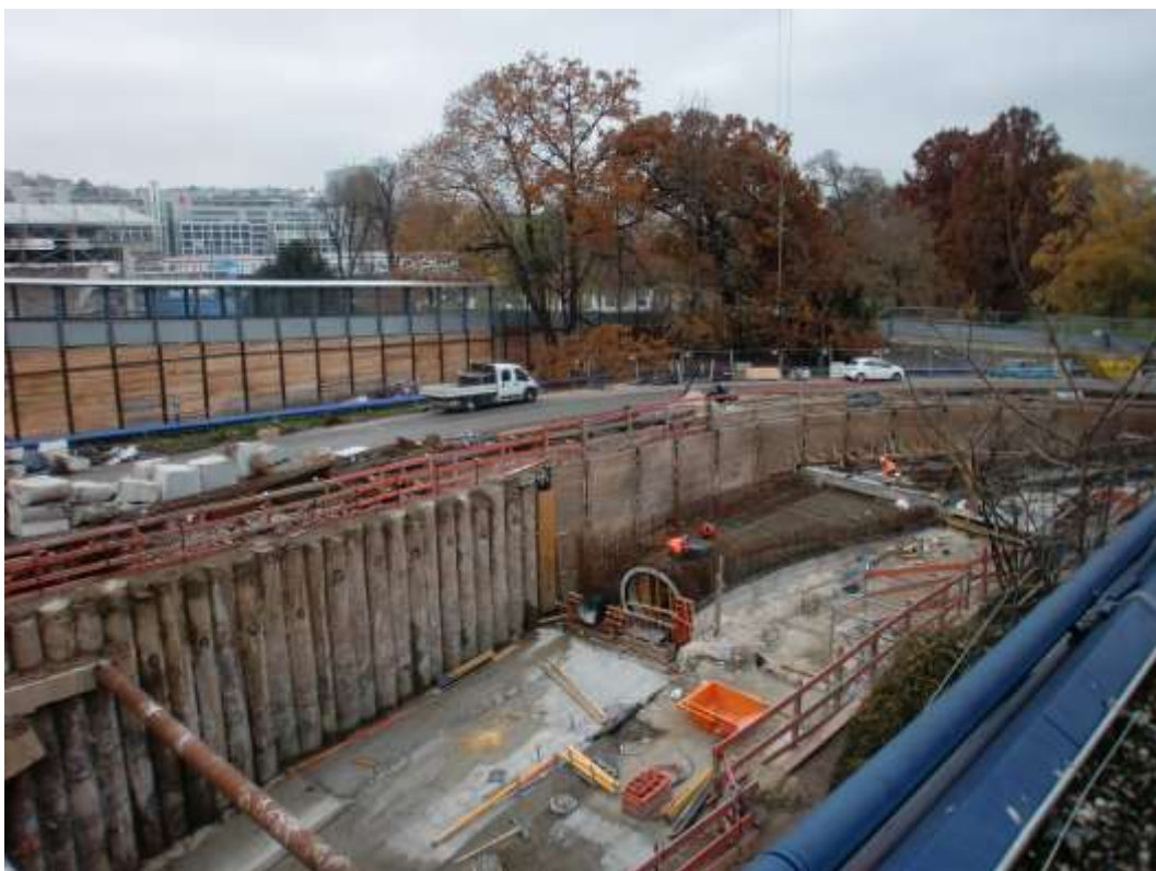
Abbildung 1: Blick auf das Baufeld Richtung Nordwest am 24.11.2016
