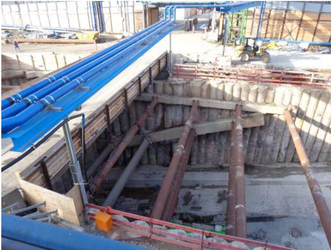
Abbildung 2: Blick auf das Baufeld Richtung West am 01.12.2016
