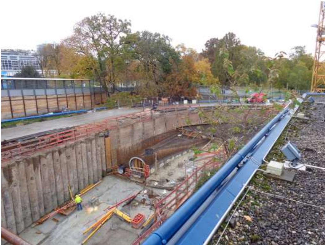
Abbildung 2: Blick auf das Baufeld Richtung Nordost am 10.11.2016
