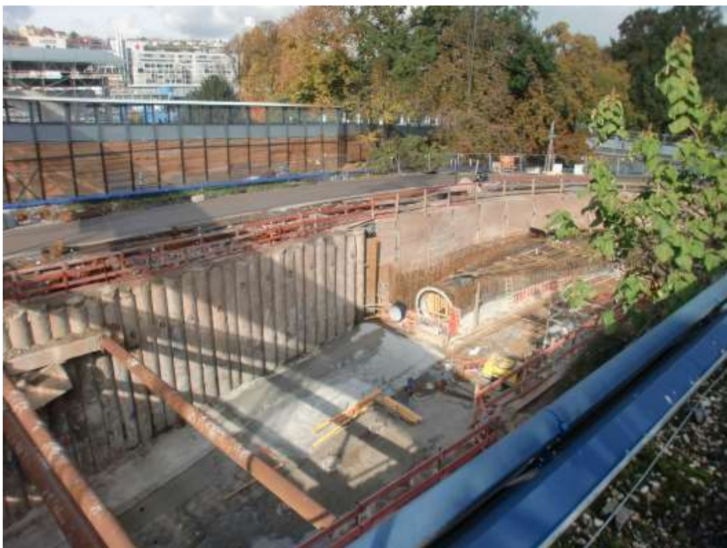
Abbildung 1: Blick auf das Baufeld Richtung Nordwest am 03.11.2016
