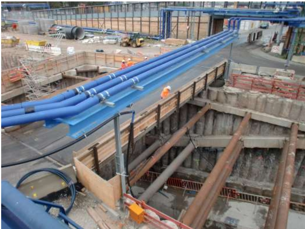
Abbildung 1: Blick auf das Baufeld Richtung Südost am 10.10.2016
