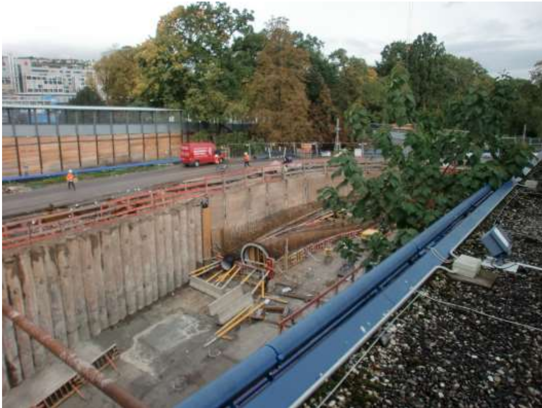
Abbildung 2: Blick auf das Baufeld Richtung Nordost am 20.10.2016
