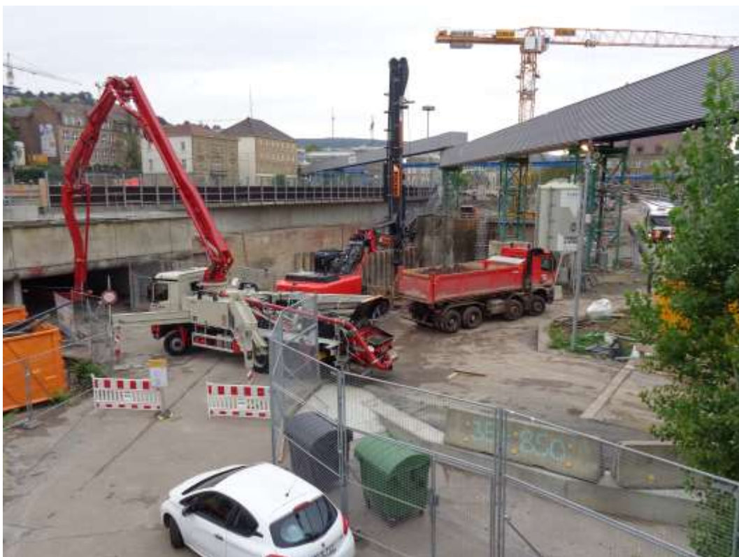
Abbildung 1: Blick auf das Baufeld Richtung Südost am 19.09.2016
