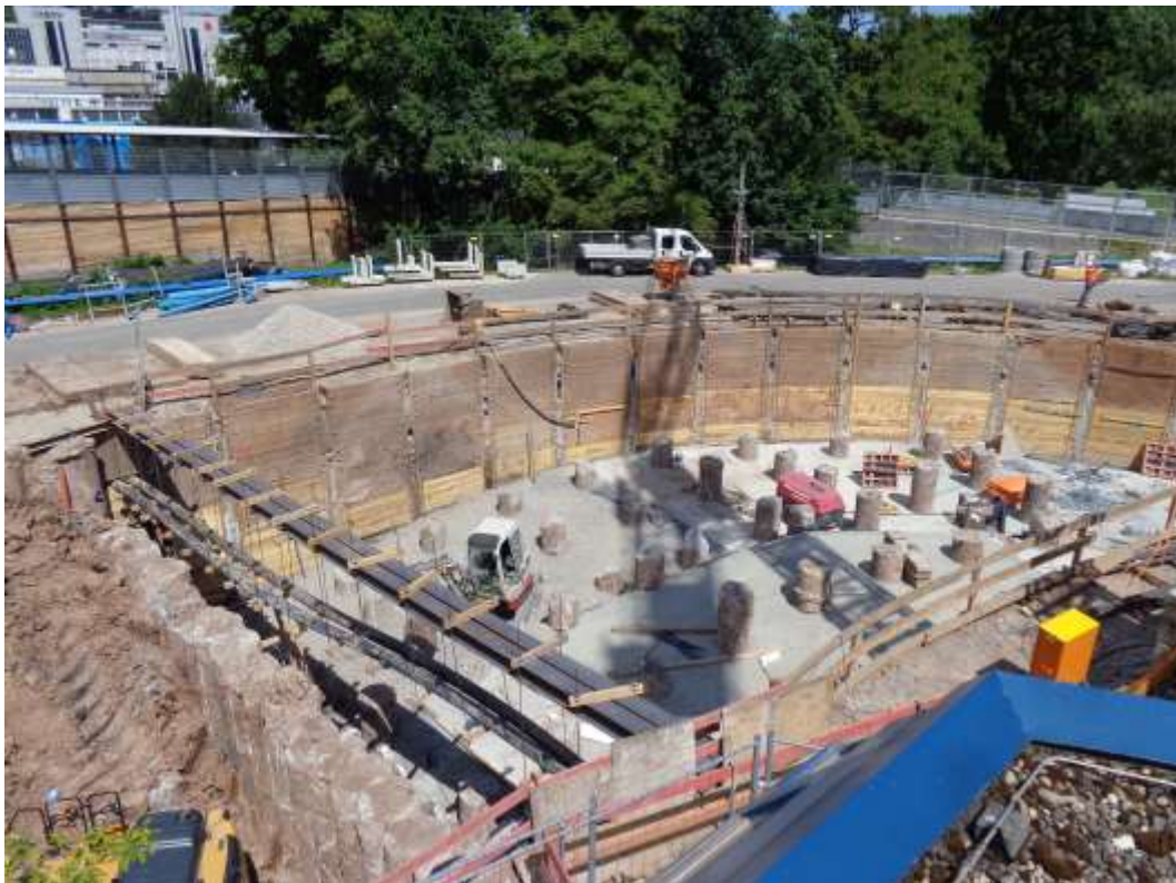
Abbildung 1: Blick auf das Baufeld Richtung Nordwest am 18.07.2016
