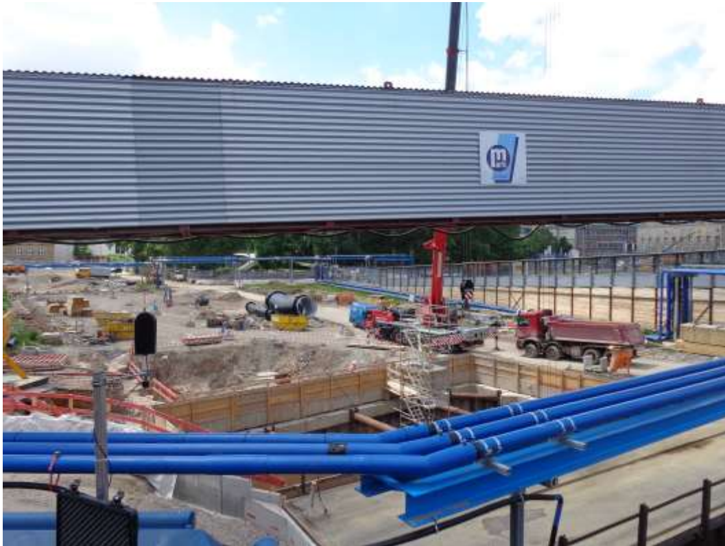
Abbildung 2: Blick auf das Baufeld Richtung Südwest am 04.07.2016
