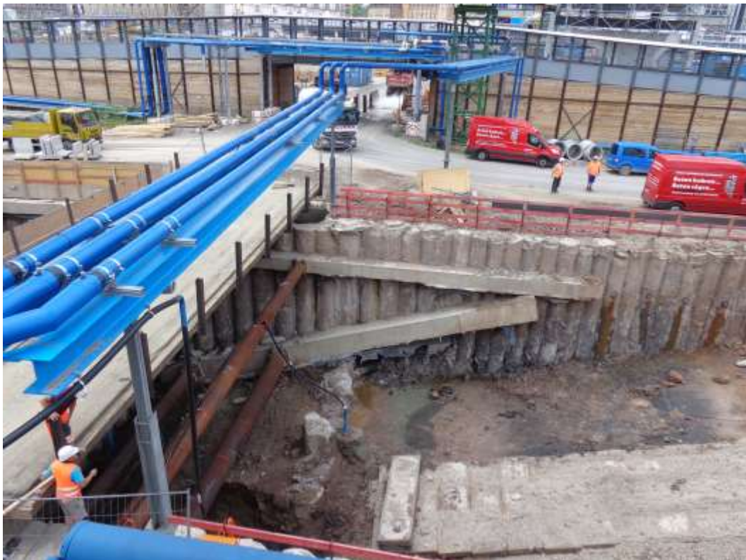
Abbildung 1: Blick auf das Baufeld Richtung West am 27.06.2016
