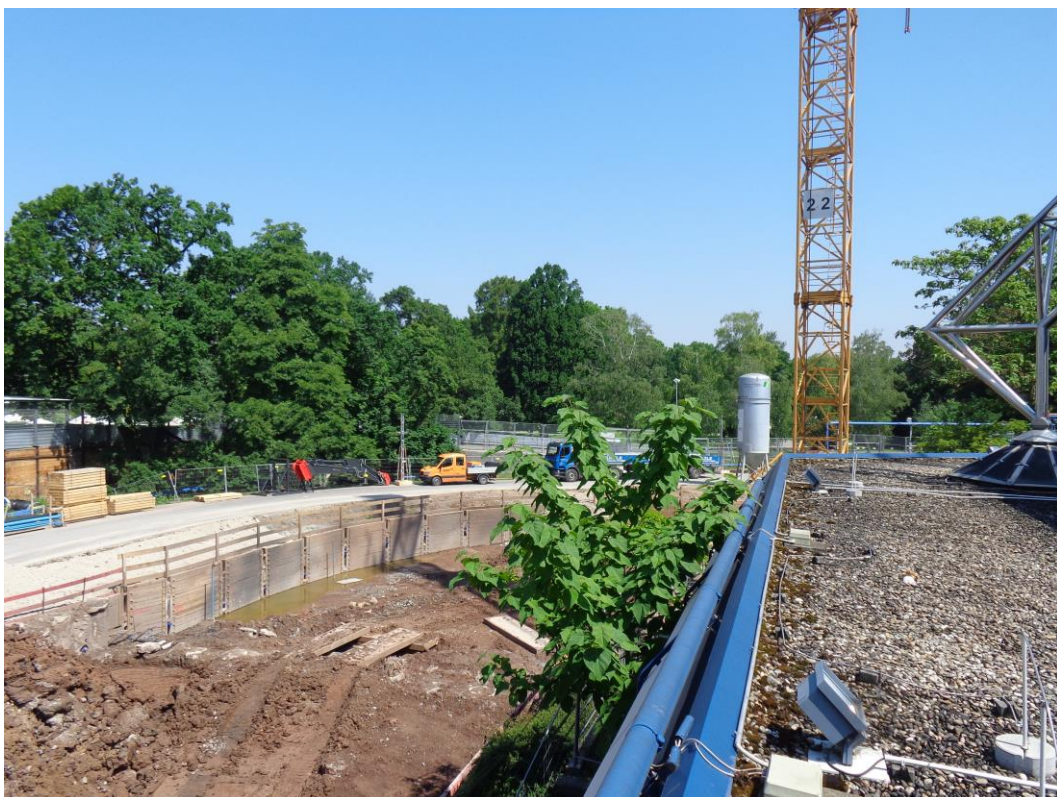
Abbildung 1: Blick auf das Baufeld Richtung Nordwest am 06.06.2016
