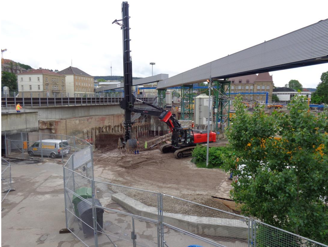
Abbildung 2: Blick auf das Baufeld Richtung Südost am 12.06.2016
