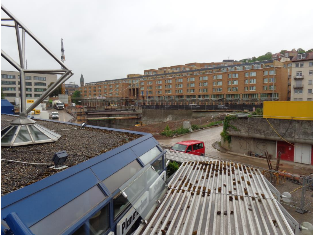
Abbildung 2: Blick auf das Baufeld Richtung Osten am 23.05.2016
