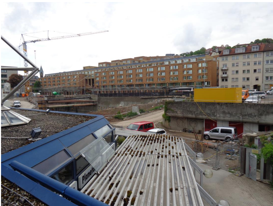
Abbildung 1: Blick auf das Baufeld Richtung Osten am 17.05.2016
