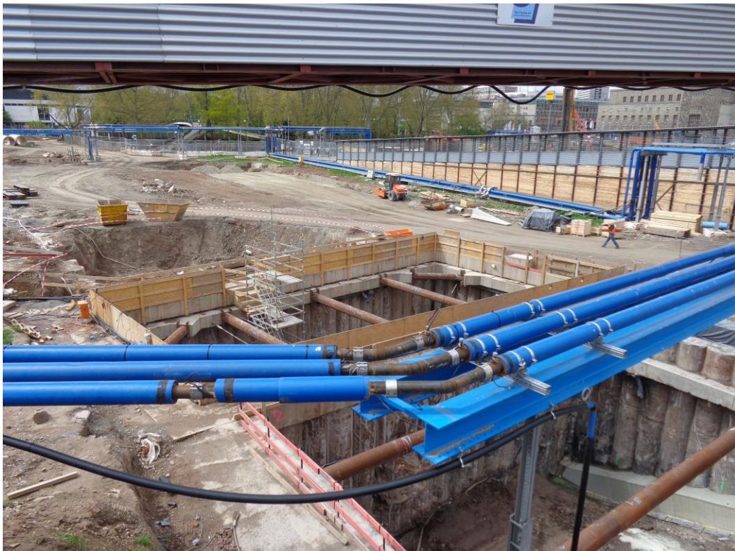
Abbildung 1: Blick auf das Baufeld Richtung Nordwesten am 25.04.2016
