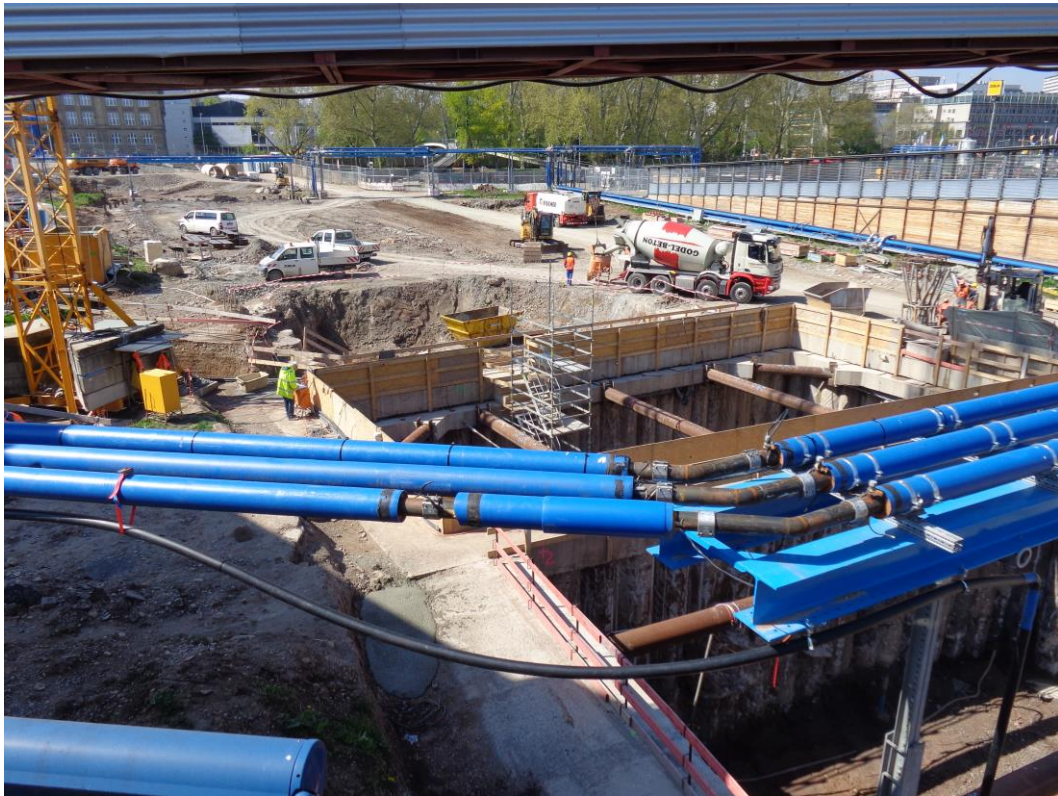
Abbildung 2: Blick auf das Baufeld Richtung Nordwesten am 02.05.2016
