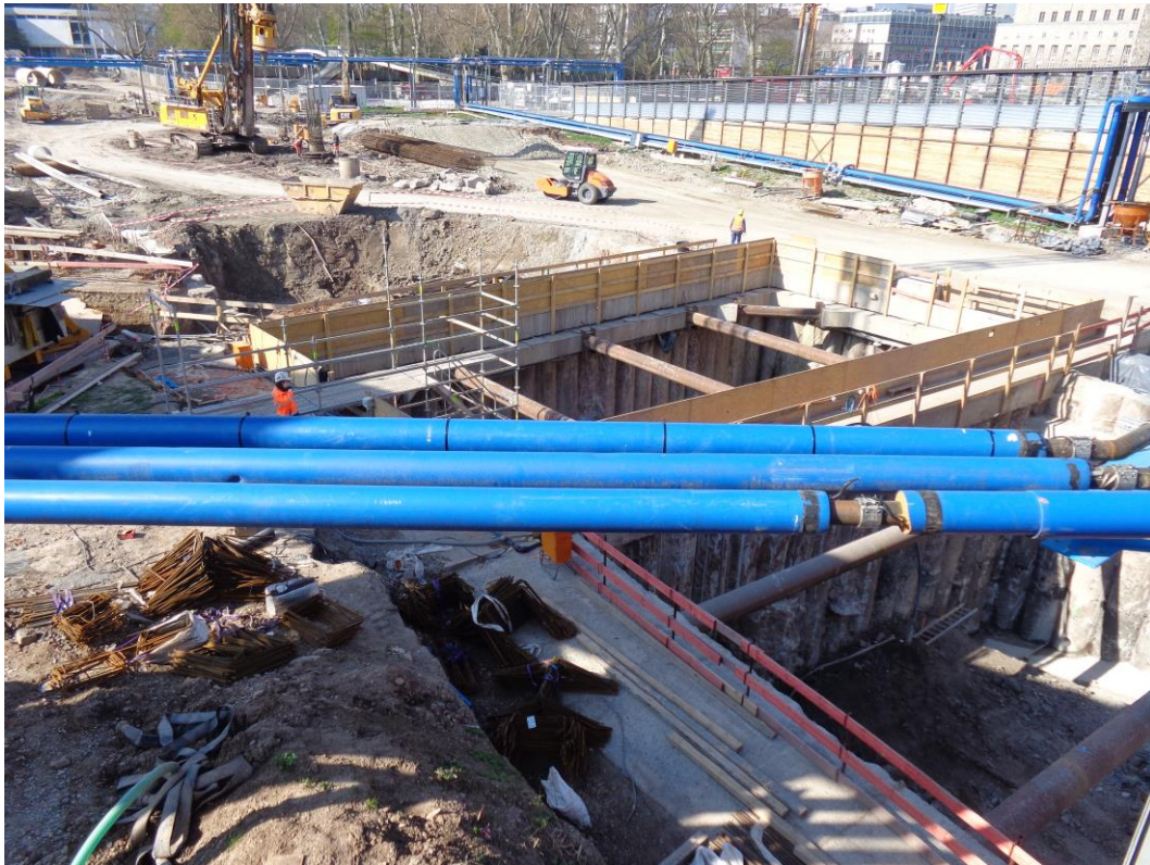
Abbildung 2: Blick auf das Baufeld Richtung Nordwesten am 11.04.2016
