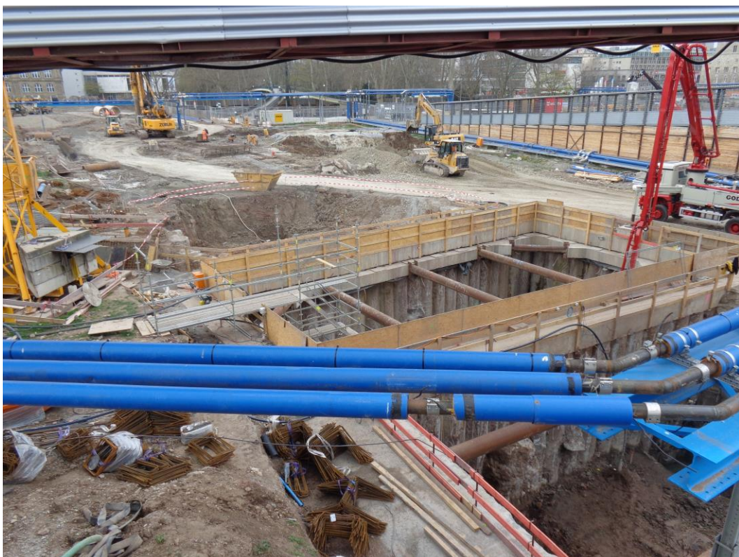
Abbildung 1: Blick auf das Baufeld Richtung Westen am 04.04.2016
