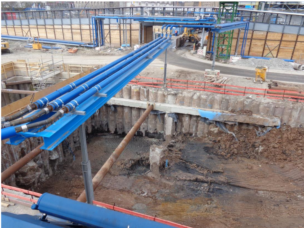
Abbildung 1: Blick auf das Baufeld Richtung Westen am 21.03.2016
