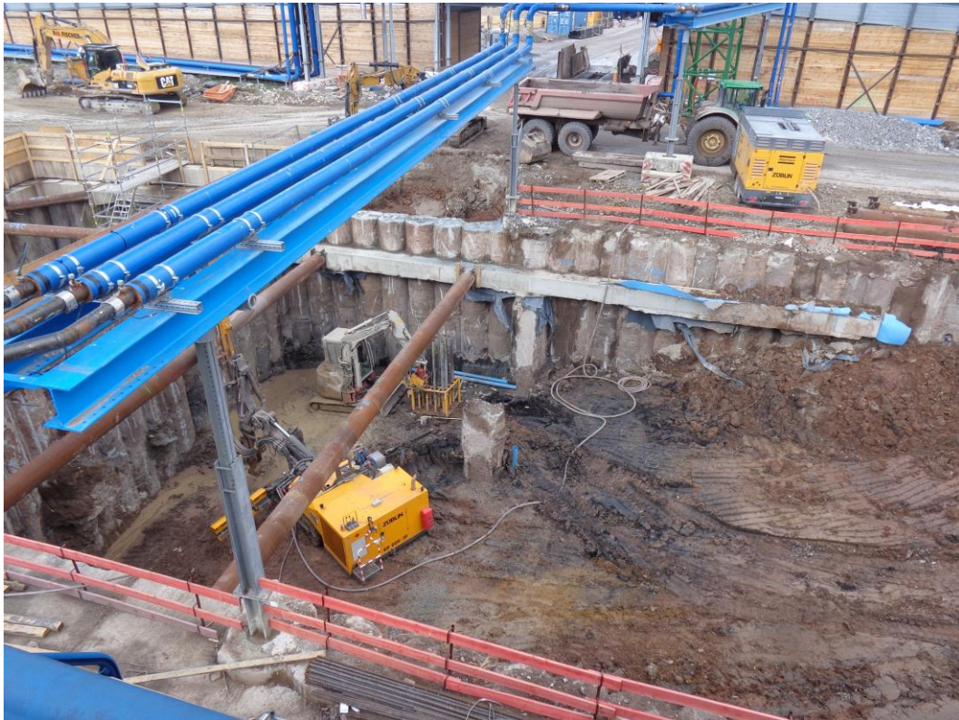
Abbildung 2: Blick auf das Baufeld Richtung Nordwesten am 29.03.2016
