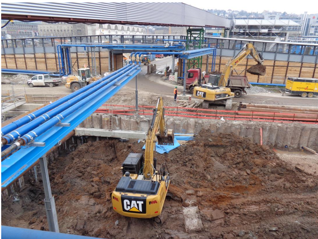
Abbildung 1: Blick auf das Baufeld Richtung Westen am 15.03.2016
