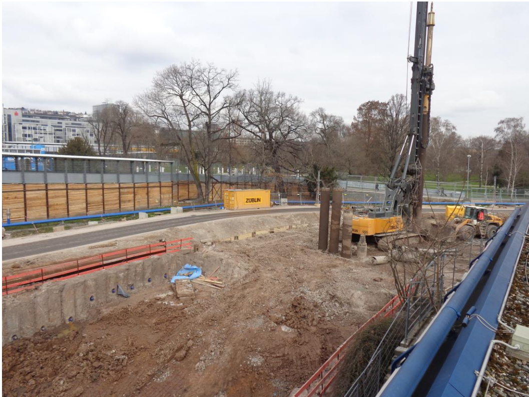
Abbildung 2: Blick auf das Baufeld Richtung Nordwesten am 21.03.2016
