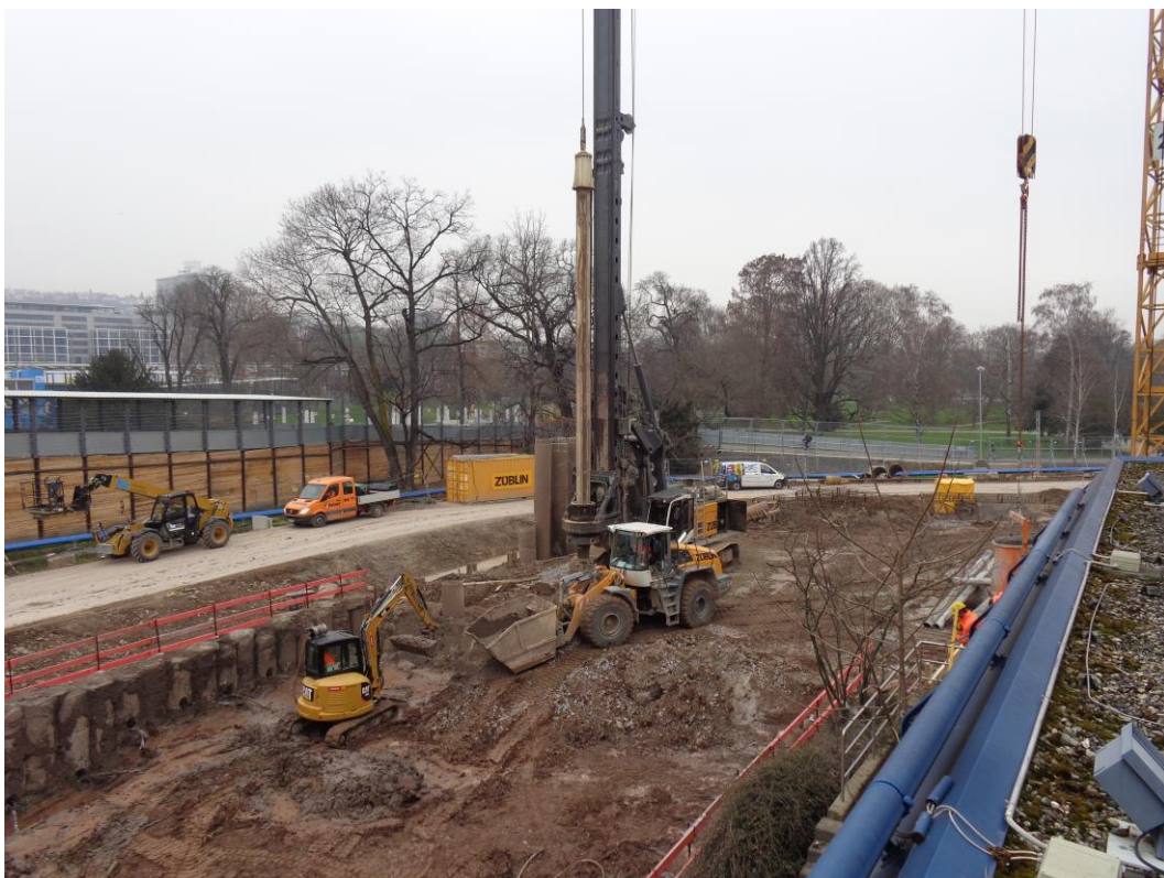
Abbildung 1: Blick auf das Baufeld Richtung Südwesten am 29.02.2016
