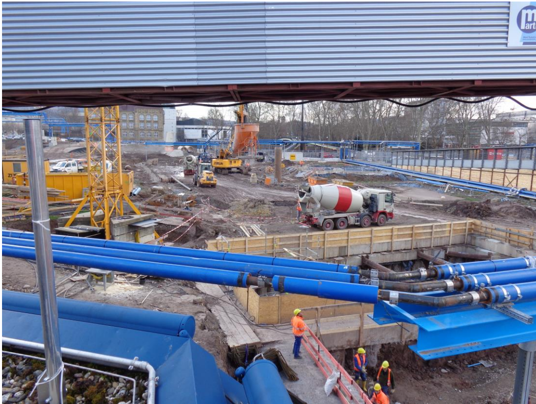
Abbildung 2: Blick auf das Baufeld Richtung Nordosten am 07.03.2016
