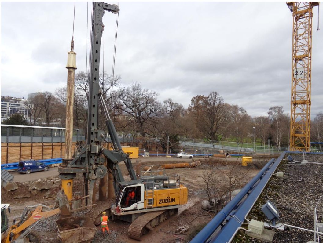
Abbildung 2: Blick auf das Baufeld Richtung Nordosten am 01.02.2016
