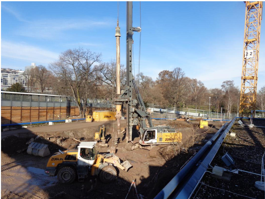
Abbildung 1: Blick auf das Baufeld Richtung Südwesten am 25.01.2016
