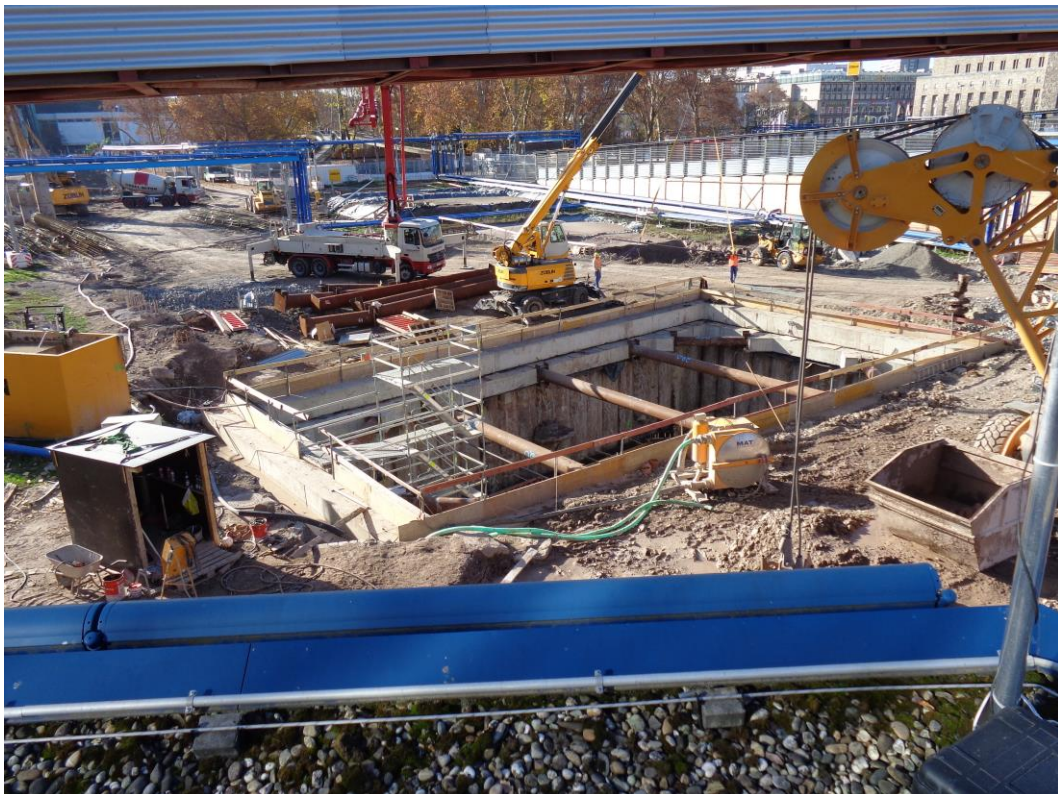
Abbildung 1: Blick auf das Baufeld Richtung Südwesten am 16.11.2015
