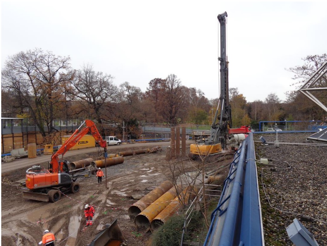
Abbildung 2: Blick auf das Baufeld Richtung Nordosten am 23.11.2015
