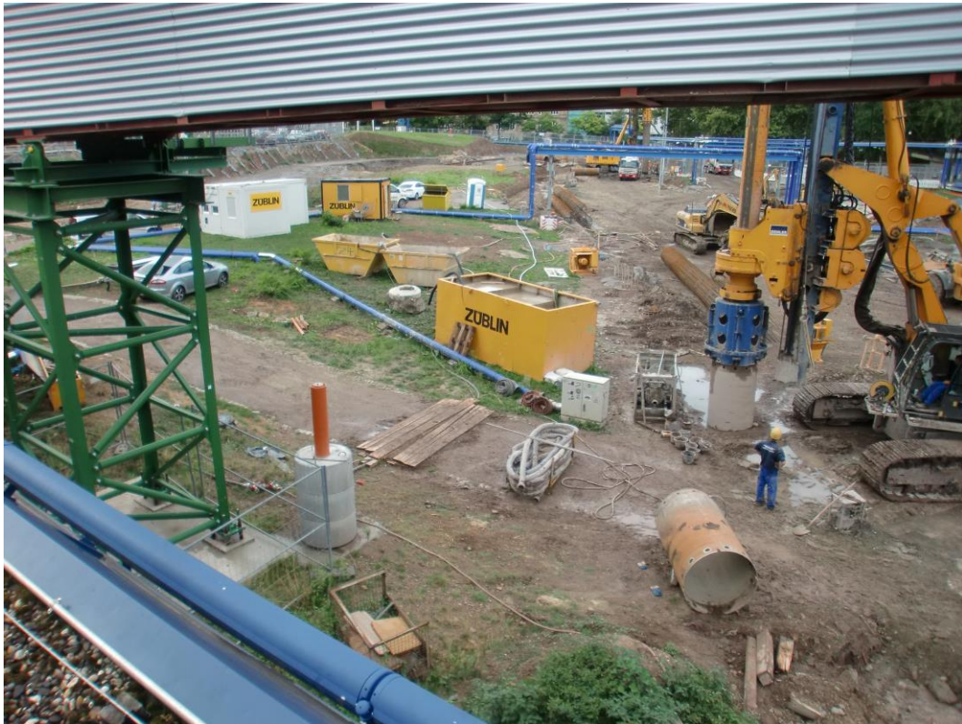
Abbildung 2: Blick auf das Baufeld Richtung Südwesten am 14.09.2015
