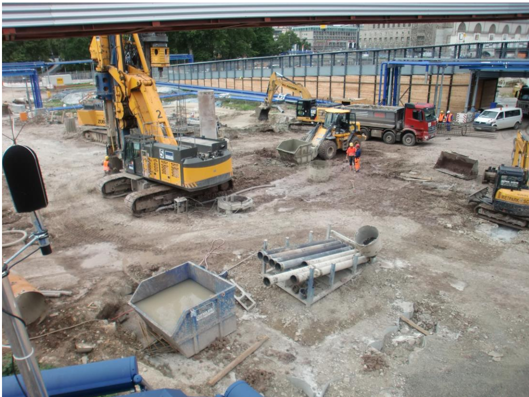
Abbildung 1: Blick auf das Baufeld Richtung Südwesten am 07.09.2015
