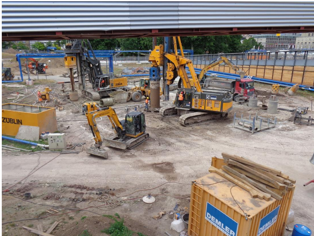
Abbildung 2: Blick auf das Baufeld Richtung Südwesten am 27.07.2015
