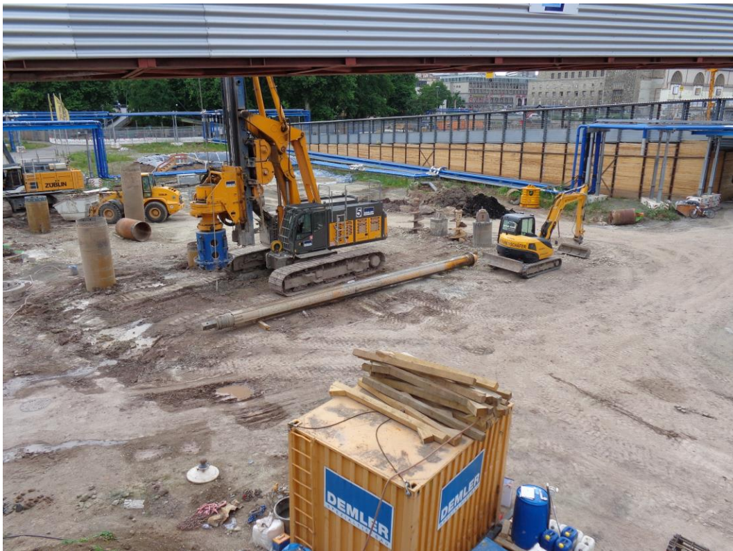
Abbildung 1: Blick auf das Baufeld Richtung Südwesten am 20.07.2015
