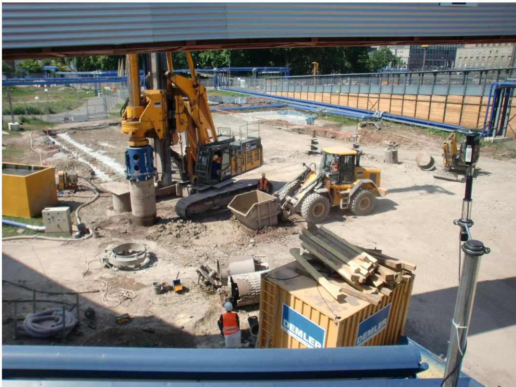
Abbildung 1: Blick auf das Baufeld Richtung Südwesten am 06.07.2015
