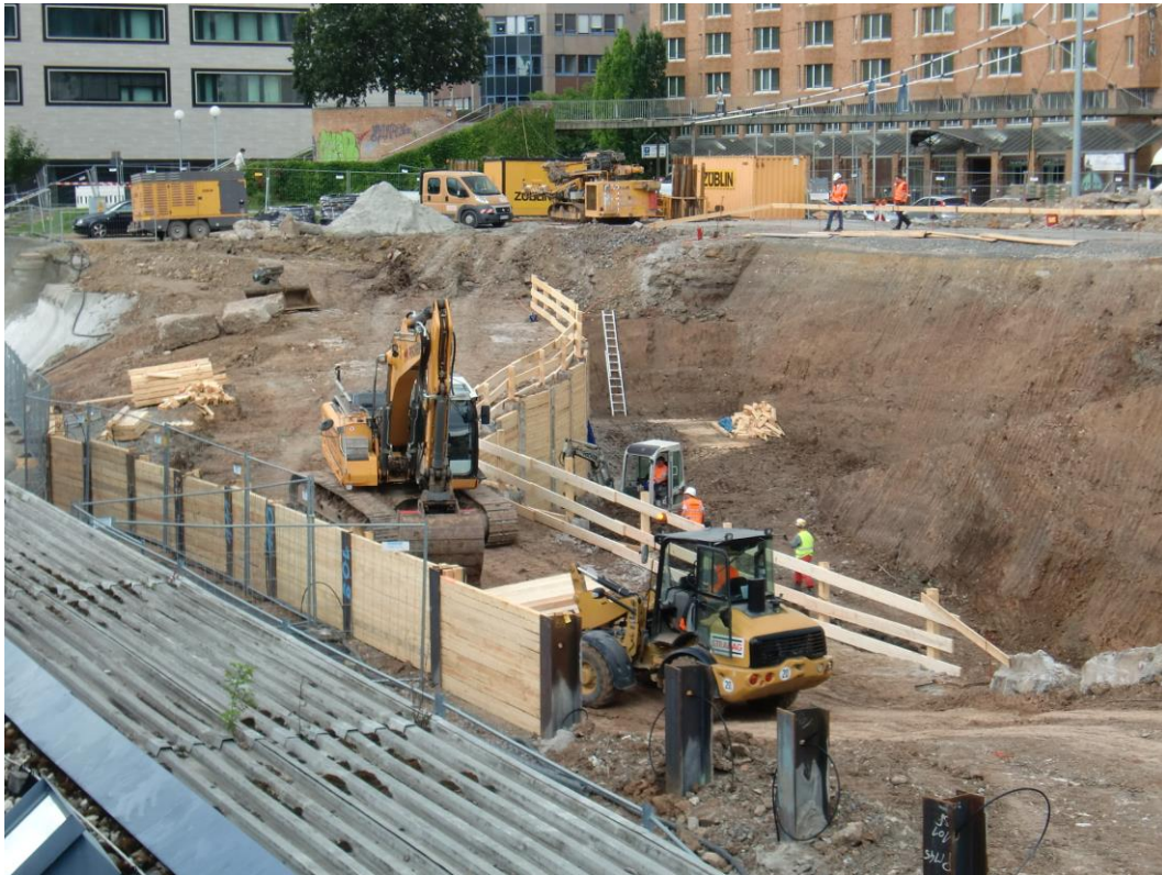
Abbildung 2: Blick auf das Baufeld Richtung Nordosten am 01.06.2015
