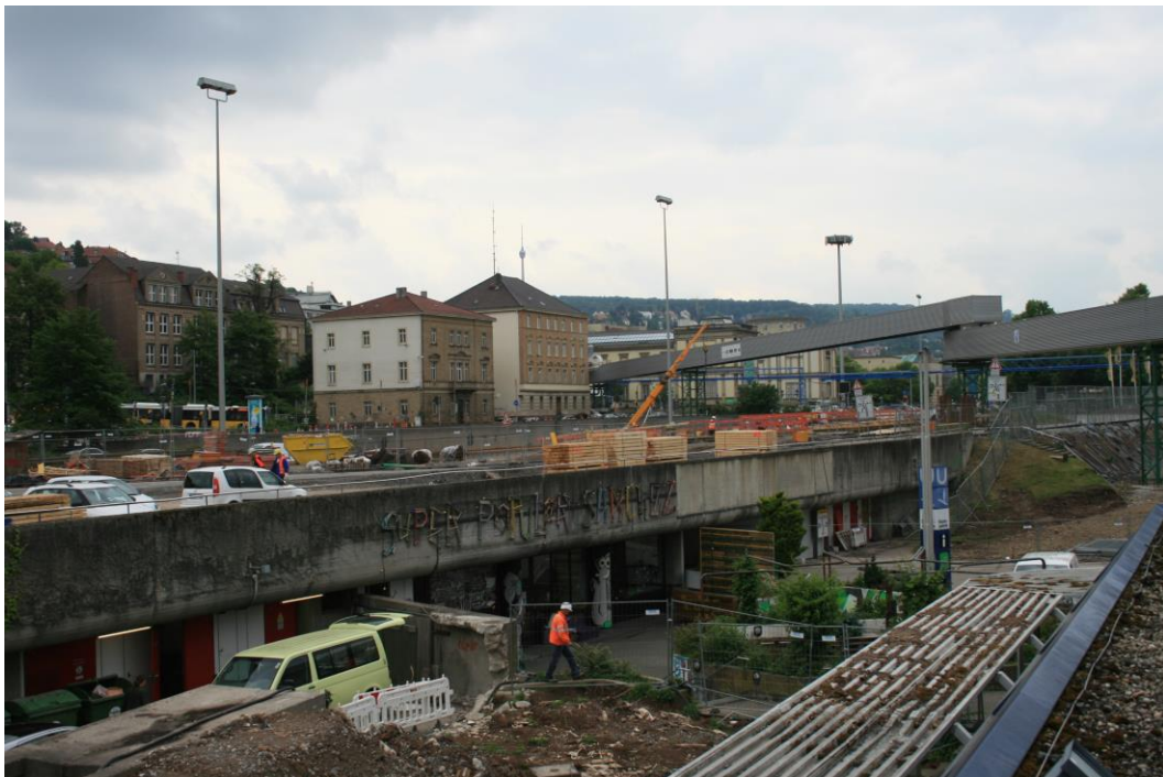
Abbildung 1: Blick auf das Baufeld Richtung Südosten am 26.05.2015
