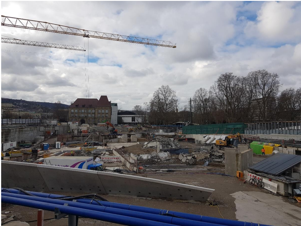
Abbildung 2: Blick auf das Baufeld bei Messende am 20.03.2023
