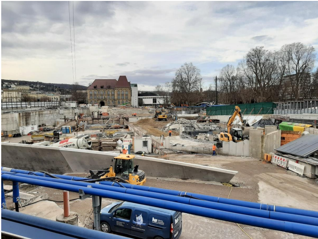
Abbildung 2: Blick auf das Baufeld bei Messende am 13.03.2023
