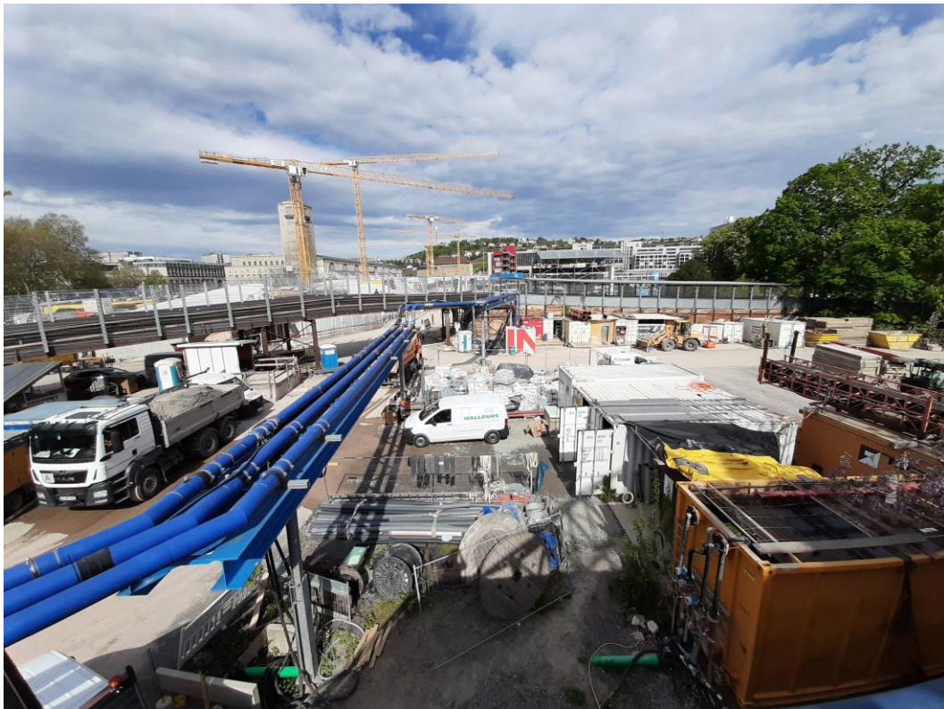
Abbildung 2: Blick auf das Baufeld bei Messende am 10.05.2021
