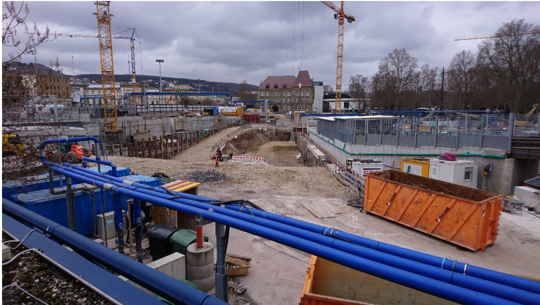
Abbildung 2: Blick auf das Baufeld bei Messende am 22.03.2021
