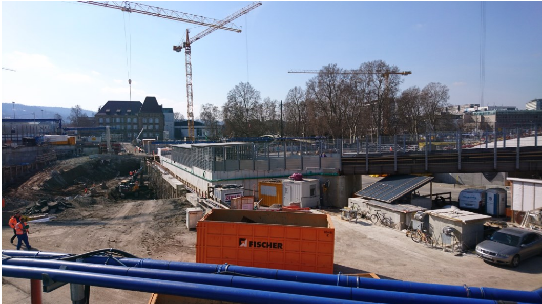
Abbildung 2: Blick auf das Baufeld bei Messende am 08.03.2021
