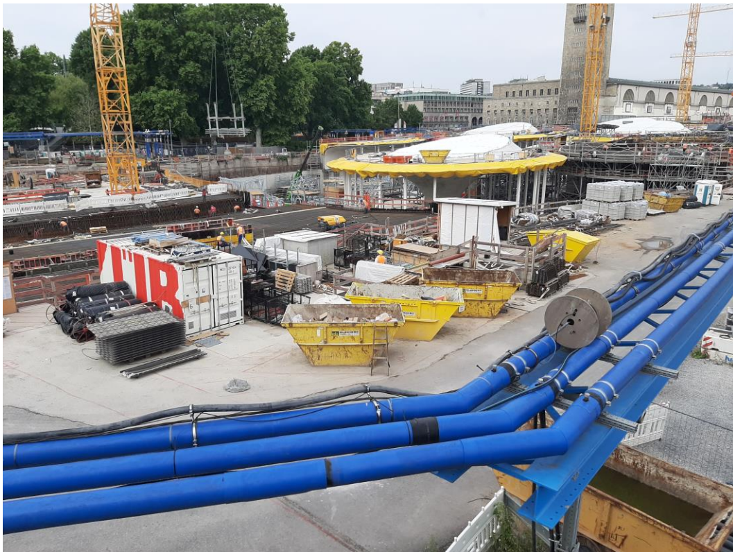
Abbildung 2: Blick auf das Baufeld bei Messende am 02.08.2020
