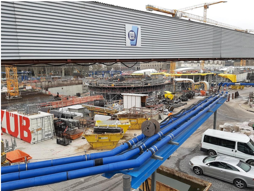
Abbildung 2: Blick auf das Baufeld bei Messende am 17.03.2020
