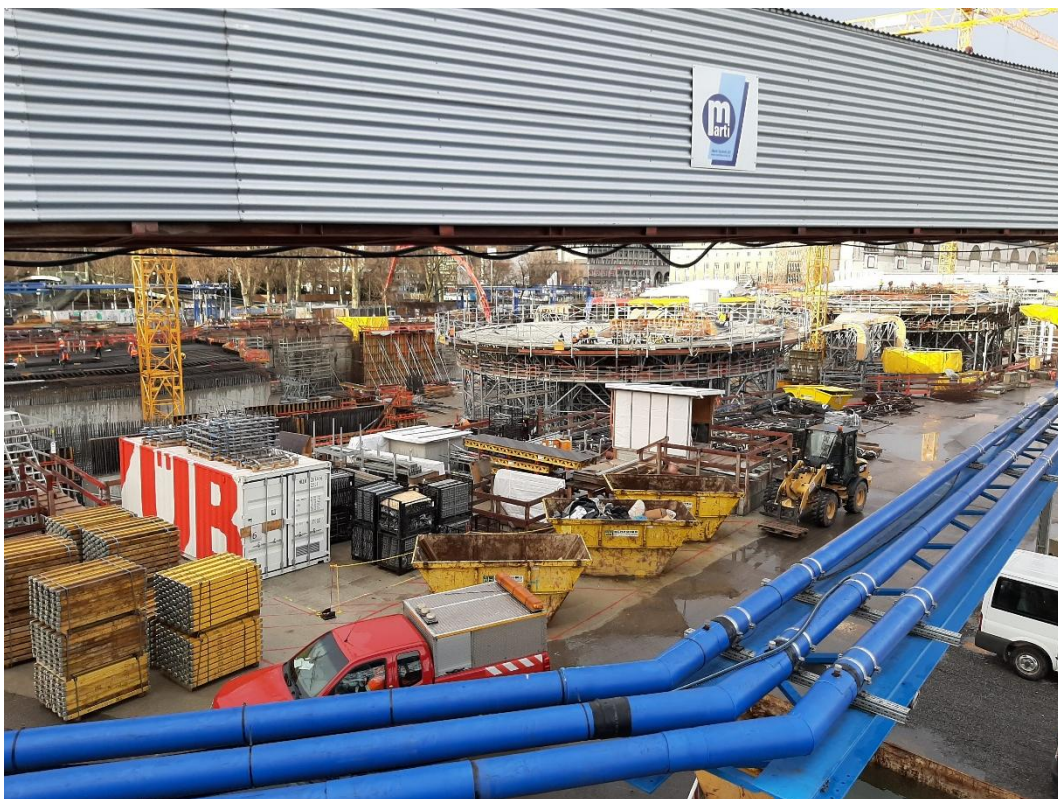
Abbildung 1: Blick auf das Baufeld bei Messbeginn am 11.02.2020
