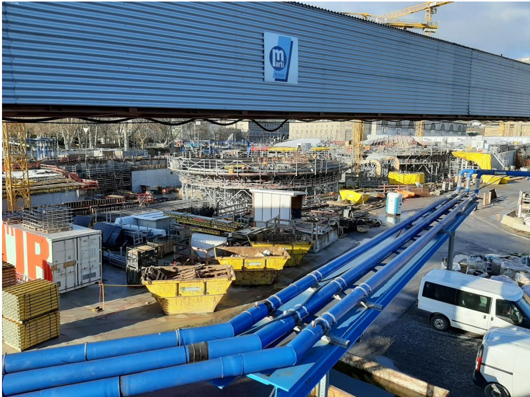
Abbildung 2: Blick auf das Baufeld bei Messende am 18.02.2020
