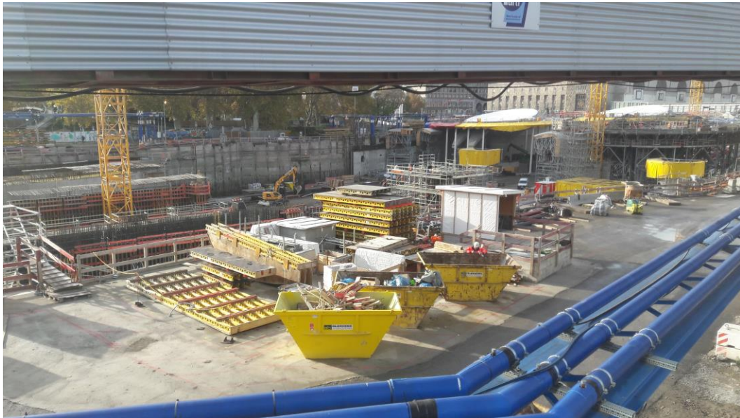
Abbildung 2: Blick auf das Baufeld bei Messende am 26.11.2019
