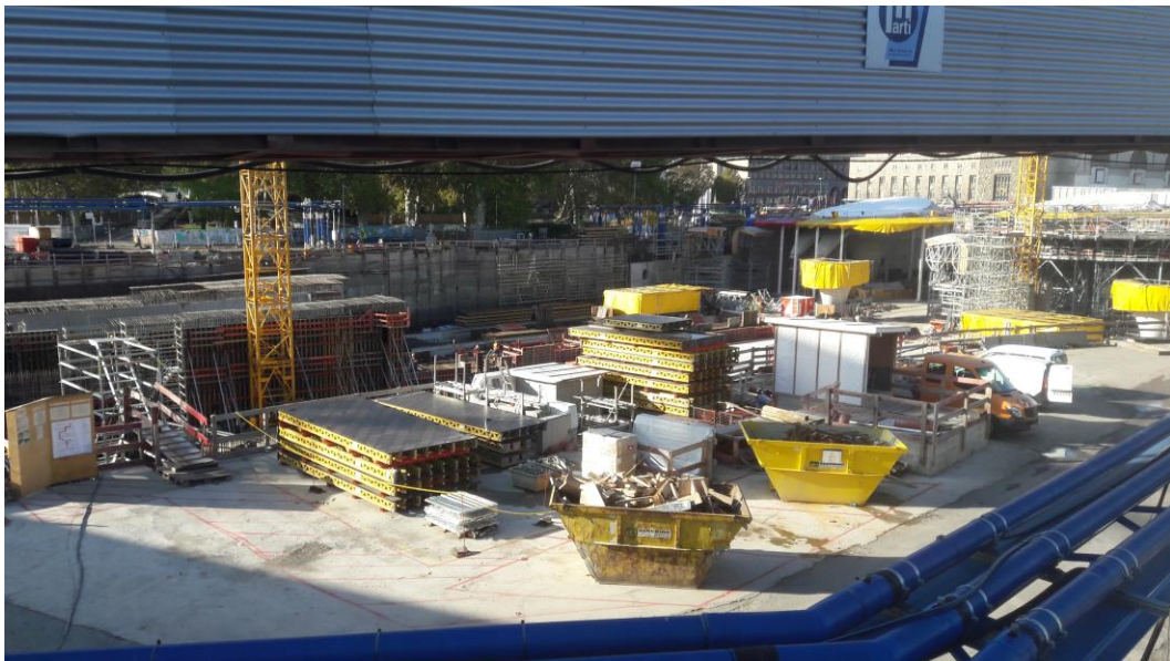
Abbildung 2: Blick auf das Baufeld bei Messende am 05.11.2019
