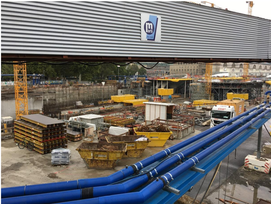
Abbildung 2: Blick auf das Baufeld bei Messende am 07.10.2019
