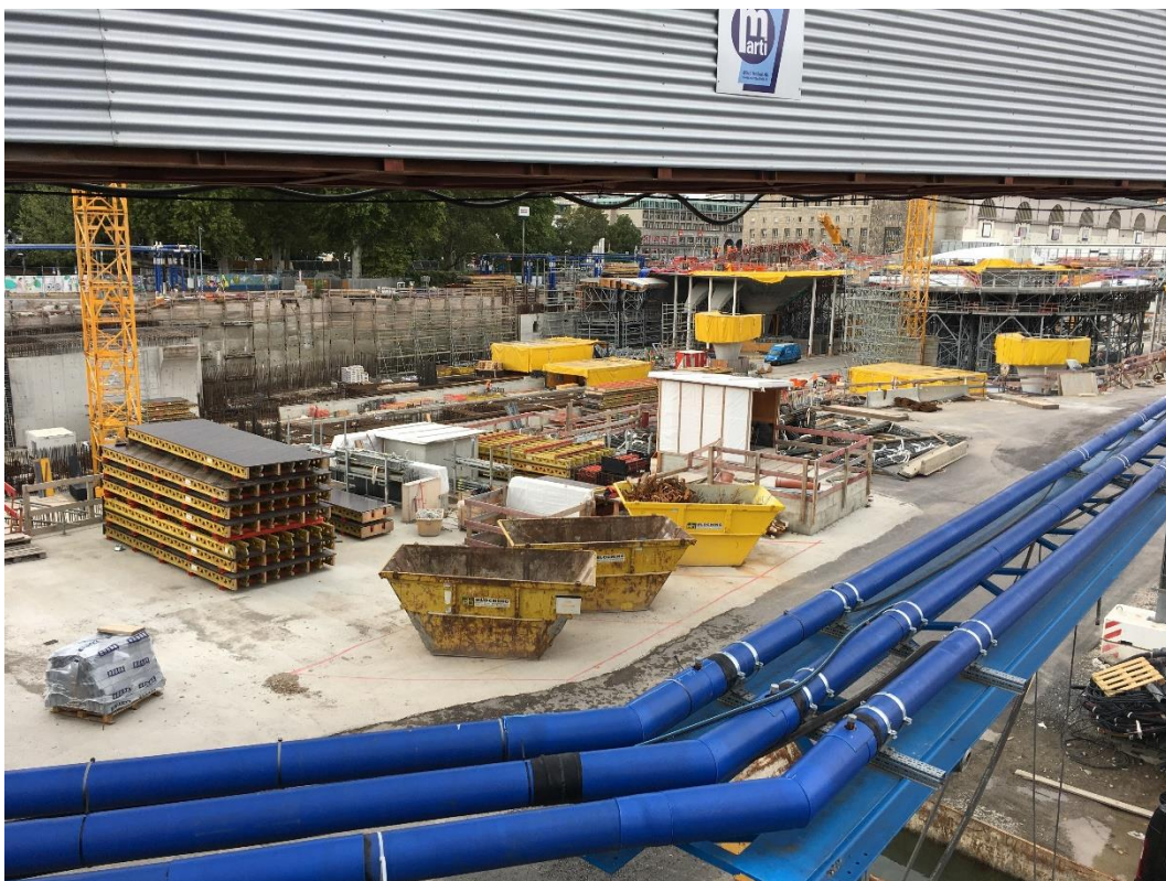
Abbildung 1: Blick auf das Baufeld bei Messbeginn am 30.09.2019
