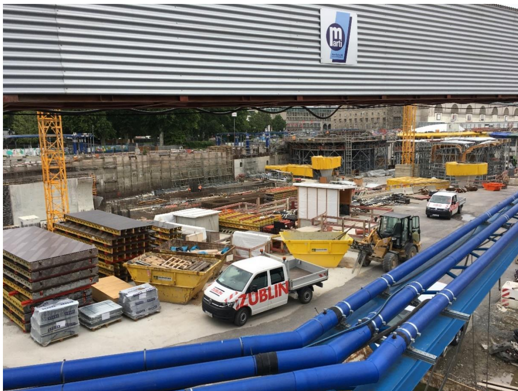
Abbildung 1: Blick auf das Baufeld bei Messbeginn am 20.08.2019
