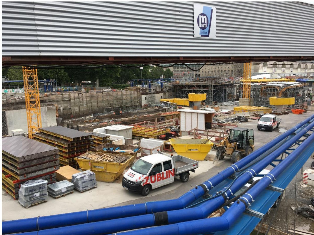
Abbildung 2: Blick auf das Baufeld bei Messende am 20.08.2019
