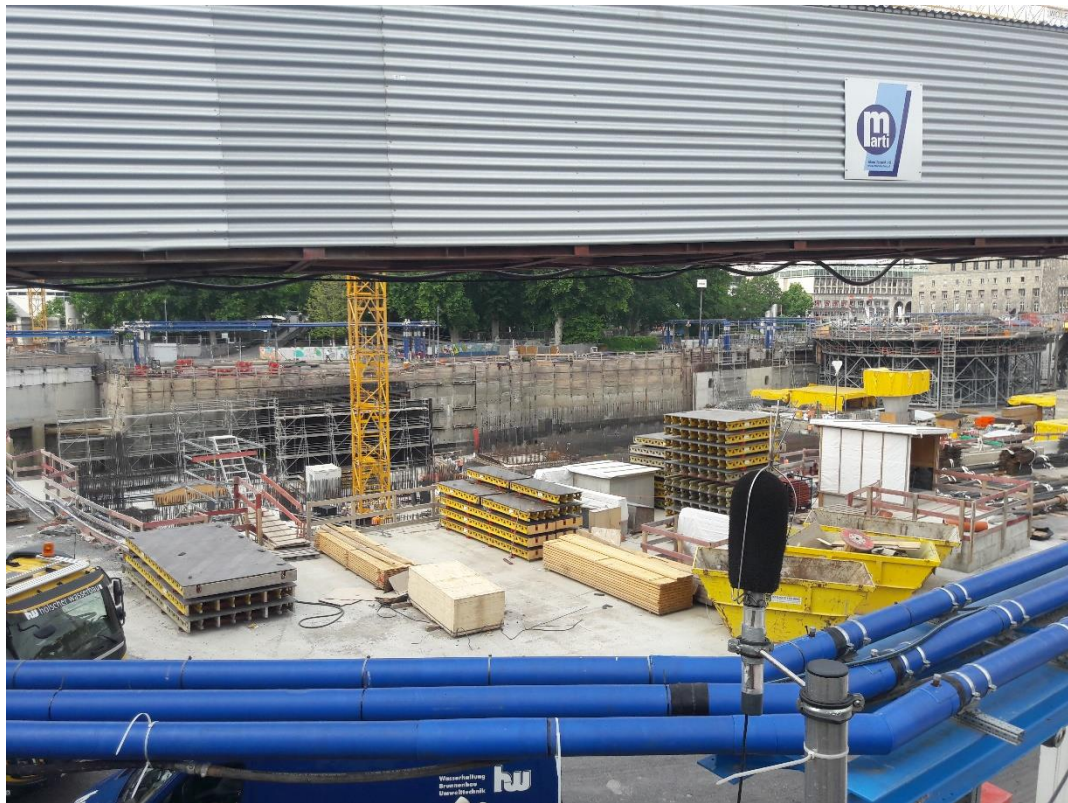
Abbildung 2: Blick auf das Baufeld bei Messende am 09.07.2019
