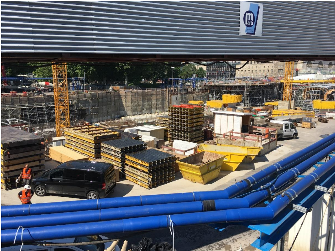
Abbildung 2: Blick auf das Baufeld bei Messende am 18.06.2019
