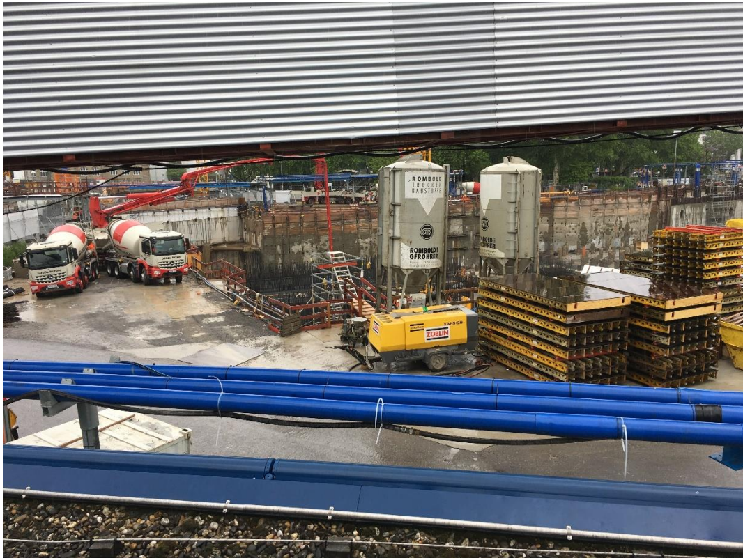
Abbildung 2: Blick auf das Baufeld bei Messende am 21.05.2019
