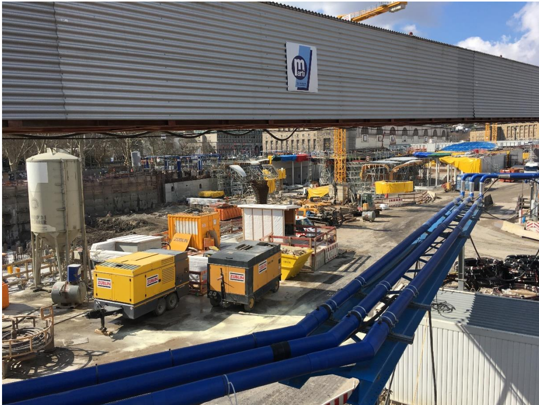
Abbildung 2: Blick auf das Baufeld bei Messende am 19.03.2019
