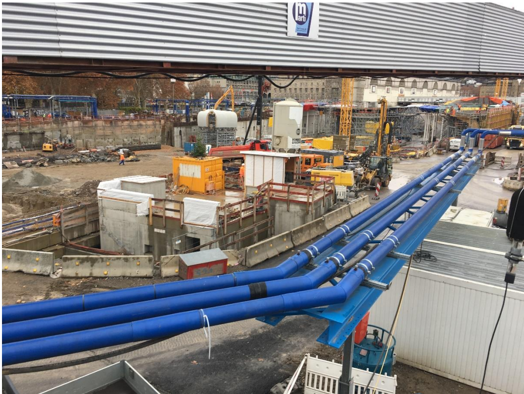
Abbildung 2: Blick auf das Baufeld bei Messende am 26.11.2018
