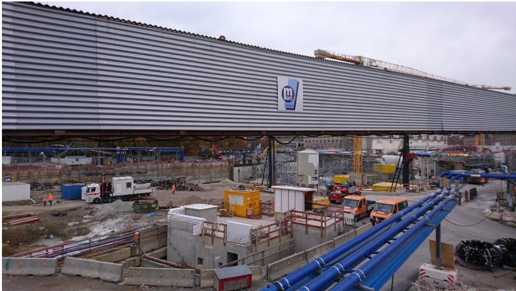
Abbildung 2: Blick auf das Baufeld bei Messende am 20.11.2018
