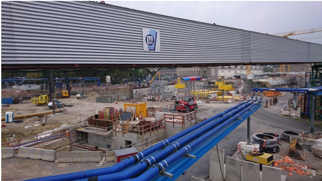
Abbildung 2: Blick auf das Baufeld bei Messende am 01.10.2018
